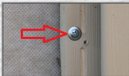
Саморез вкручен не в перфорационное отверстие и до упора
