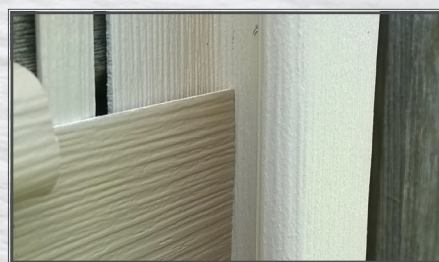
Панель смонтирована вплотную, что КАТЕГОРИЧЕСКИ ЗАПРЕЩЕНО!
