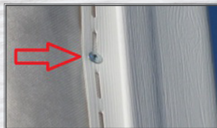
Саморез вкручен не в перфорационное отверстие и до упора
